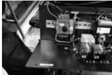
3. Se recomienda checar primero el estado del Relay. El relay se acciona si hubo un cortocircuito, una subida en el consumo del motor o la falta de una de las 2 fases; esto puede causar que se active la función de seguridad y “bote” el relay. Para restablecerlo solo hay que girar la perilla a la posición “I” (Imagen 16).
